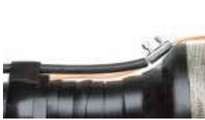
Uzemněné propojení stínění
