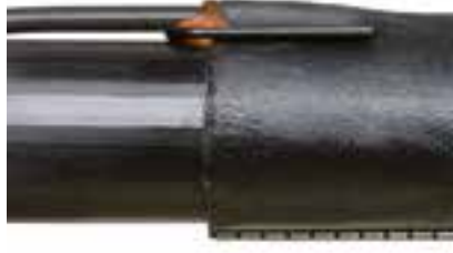
Přerušené propojení stínění pro transpozici
